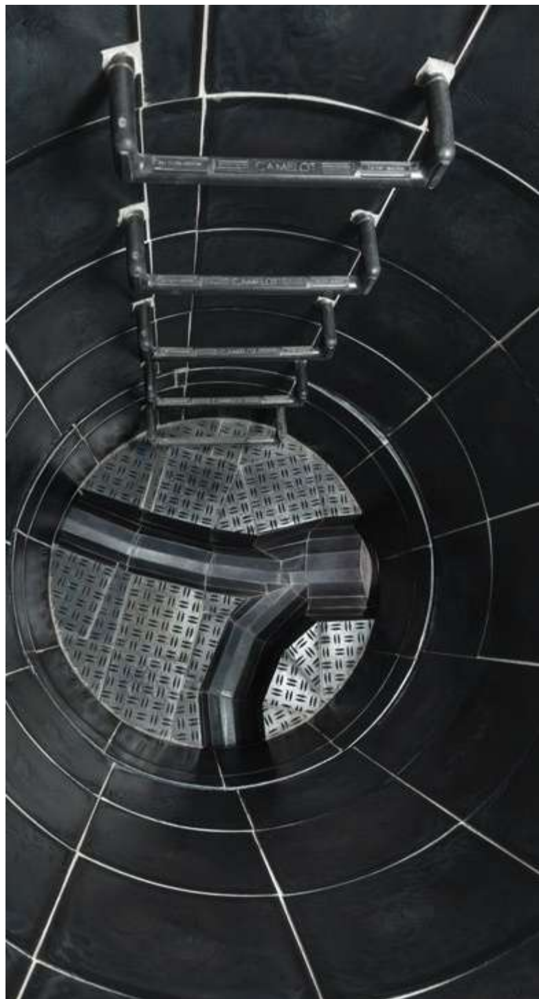
Vnitřní obklad spadišťové šachty čedičem
