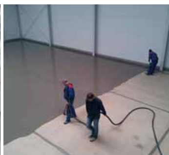
Povrchová úprava s vyrovnávací vrstvou při rekonstrukci průmyslové podlahy
