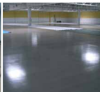
Vyrovnání průmyslové podlahy pod syntetickou stěrku
