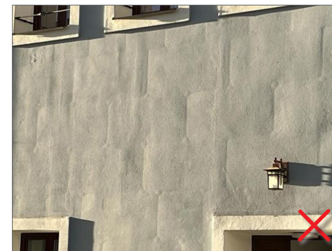
Poškozený ETICS vlivem polštářového efektu a nevhodného kotevního schématu
