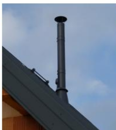
Nerezový komín lakovaný podle odstínu krytiny
