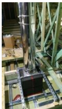
Založení na stropní konstrukci
