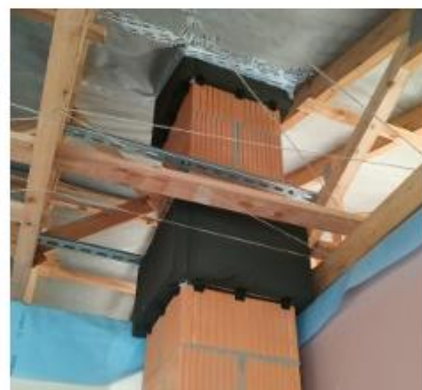
Parotěsné prostupy na cihelném komíně
