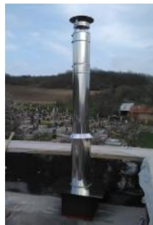
Prostup a vysoké lemování na ploché střeše
