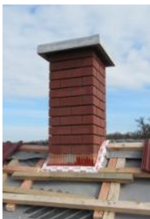
Bezpečný vstup komína střešní konstrukcí
