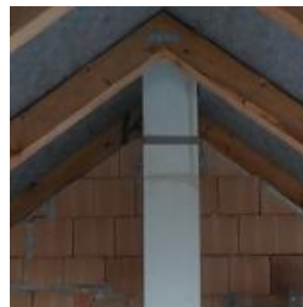
Průběžné kotvení stěnovým úchtem
