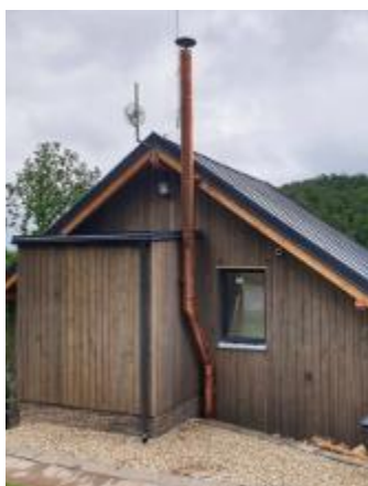
Galvanicky poměděný fasádní nerezový komín
