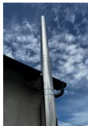
Statické spony pro volné vyložení až 4 m
