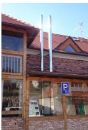
Novostavba s nerezovými komíny
