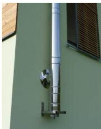
Fasádní komín na konzoli s čištěním spodem
