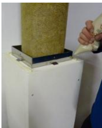
Slepování šachetních dílů COMPACT
