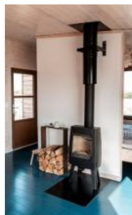
Lakovaný svislý kouřovod s funkcí komína
