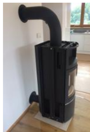
Napojení kamen na přívod vzduchu
