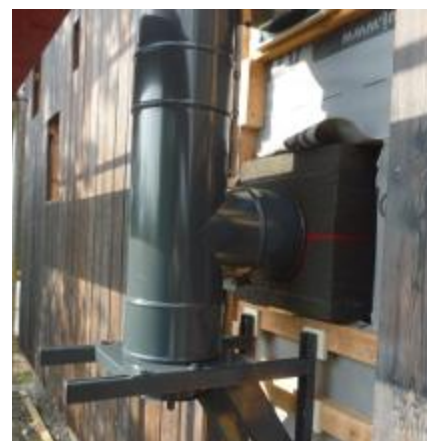
Parotěsný vstup kouřovodu
