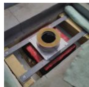
Detail založení v ploché střeše
