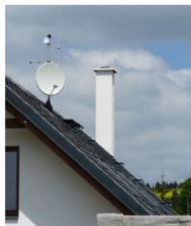
Omítnutá základní nadstřešní část
