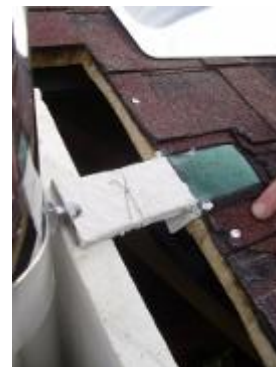
Příklad uchycení střešního držáku
