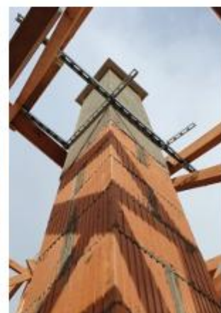
Kotvení komínu CIKO ke krovu
