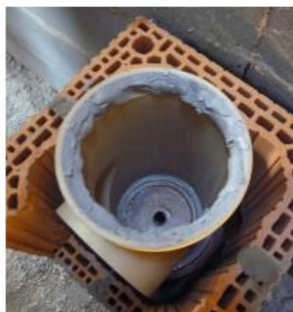
Spárovací hmota v hrdle vložky CIKO TEC
