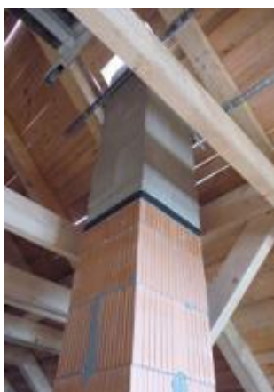
Přerušení tepelného mostu v úrovni stropu
