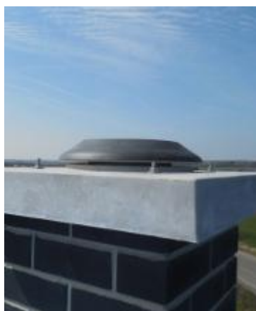
Krycí deska s přívodem vzduchu
