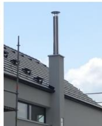
Nerezový nástavec založený nad střešou
