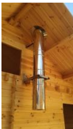
Příklad založení svislého kouřovodu
