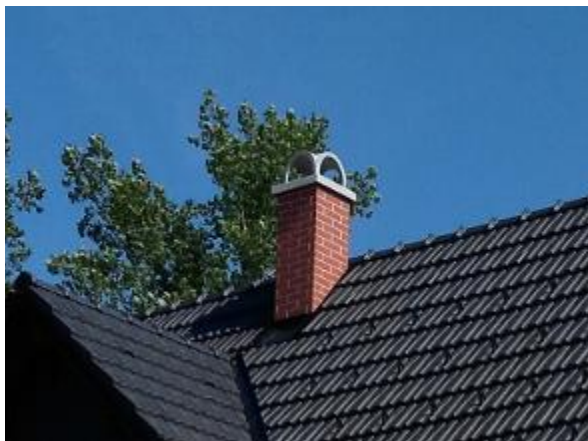
Realizace s návkem Imit a historickou hlavicí
