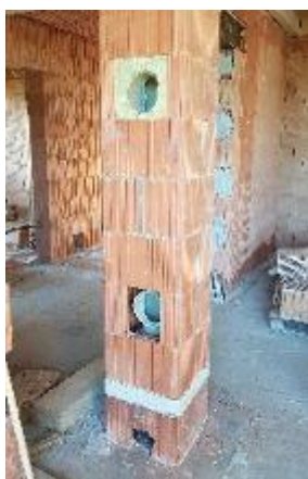
Příprava na přívod vzduchu podlahou
