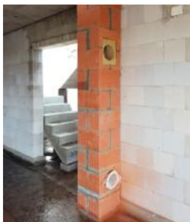
Příprava na přívod vzduchu z boku
