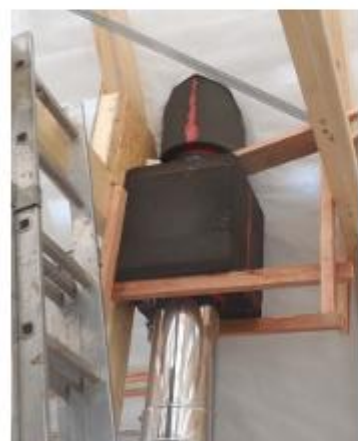
Parotěsné prostupy na nerezovém komíně
