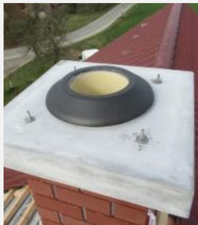
Příšroubovaná krycí deska pro přívod vzduchu
