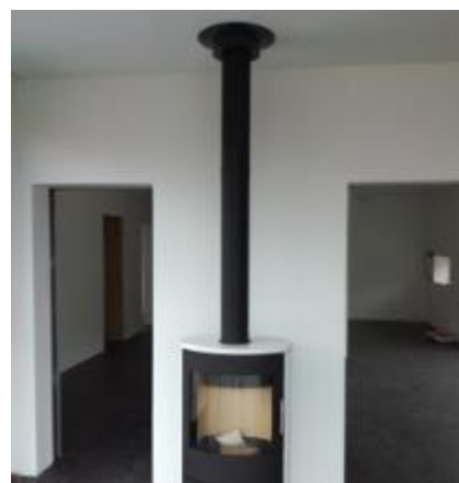
Lakovaný svislý kouřovod s funkcí komína
