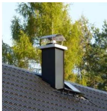
Oplechovaná základ nadstřešní část s oblou stříškou
