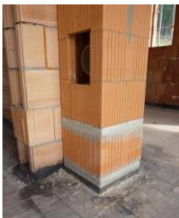
Přerušení tepelného mostu pod komínem
