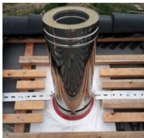
Využití těsnící manžety HotSchott a střešního držáku
