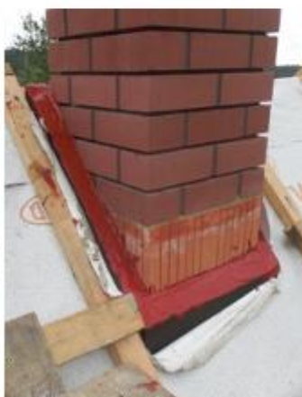
Parotěsný vstup cihelného komína
