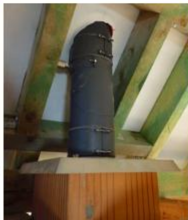
Nerezový nástavec založený pod střešou
