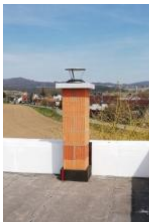
Parotěsný vstup plochou střechou
