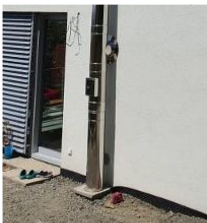
Komín založený na krátkitelném podstavci
