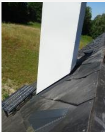
Detail přesazení náleku štuko přes lemování
