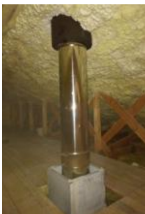
Přechod na nerezový nástavec
