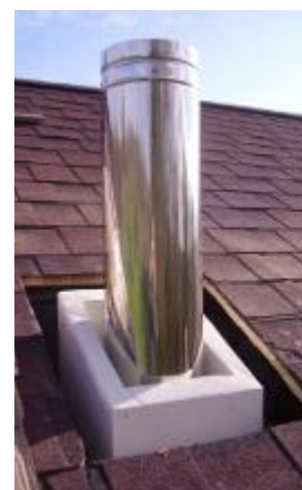
Realizace s nerezovým nástavcem
