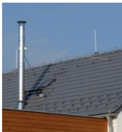
Kotvení komínu pomocí teleskopických tyčí
