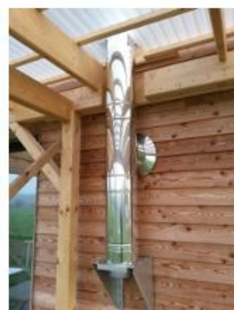
Nerezový komín založený na konzoli
