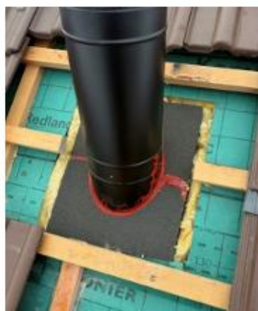
Parotěsný vstup GPKS v šikmé střešní konstrukci
