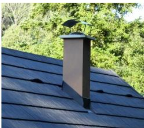
Omítnutý základ s oblou stříškou
