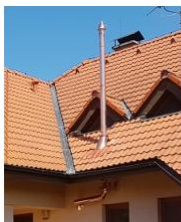
Poměděný fasádní nerezový LAS systém
