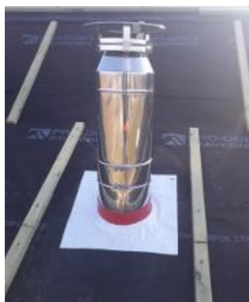
Manžeta HOTSchott nalepená k pojistné hydroizolaci
