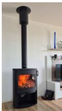
Lakovaný svislý kouřovod
