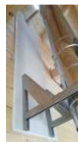
Založení na stěně
