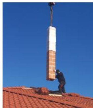
Instalace systému monoTEC pomocí jeřábu
