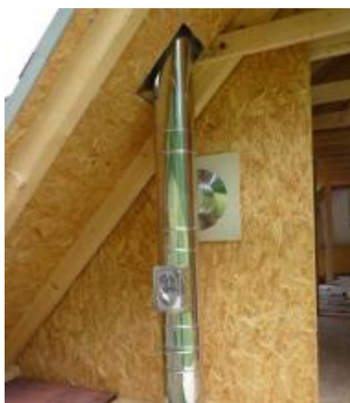
Prostup kouřovodu
