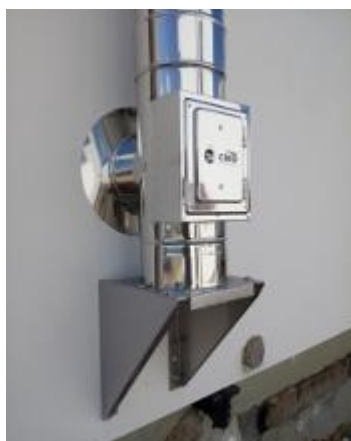
Fasádní komín na konzoli s dvířkovým dílem
