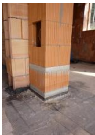
Přerušení tepelného mostu na hrubé podlaze
