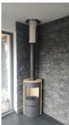
Svislý kouřovod s funkcí komína
