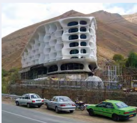
Venkovní prostory, komplex Barin, Írán
