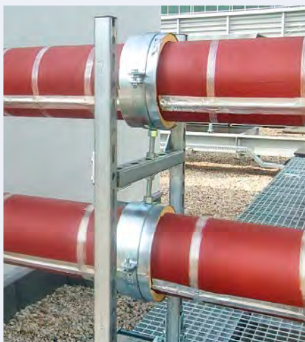
Ochrana potrubí, Polsko
