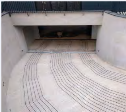
Vjezd do podzemní garáže, Záhřeb, Chorvatsko
