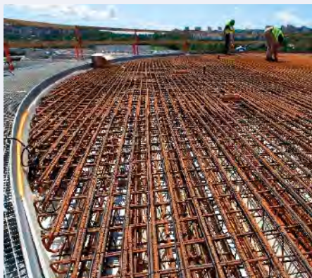
Heliport, nemocnice Bory, Bratislava, Slovensko
