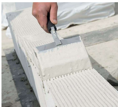
Vytváření ložných spár: vlevo – pórobeton, vpravo – vápenopiskové bloky
