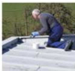
Korozi napadená místa opatřete nátěrem antikoroziční barvy
