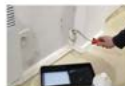
Aplikujte penetraci na zeď a nechte ji zaschnout aspoň 8 hod.
