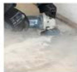
Po zaschnutí přebrouste povrch vibrační nebo úhlovou bruskou
