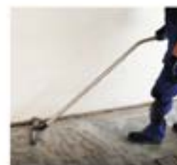
Vysajte povrch po broušení
