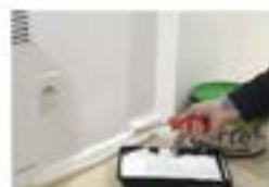
Provedte druhý nátěr a nechte ho zaschnout
