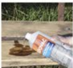
Aplikujte odšedovač (liti, stříkání)
