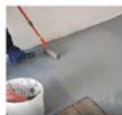
Finální nátěr podlahy technikou křížového nátěru
