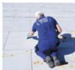
Ošetřená plocha po aplikaci antikorozičního nátěru
