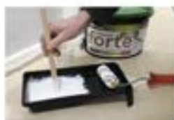
Rozmíchejte barvu. První vrstvu zředte více a to cca 10–20 % vody
