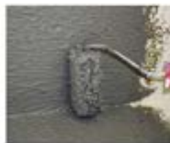
Aplikace: štětcem, hladítkem nebo válečkem
