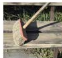
Povrch mechanicky očistěte
