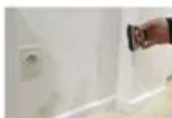
Nechte vyschnout aspoň 24 hodin a odstraňte plíseň kartáčkem
