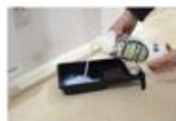
Připravte si protiplísňovou penetraci Rokoground Antibac, která se neředí
