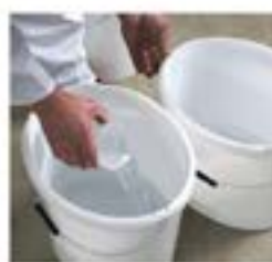
Nalijte vodu do nádoby a přidejte prášek (ROKOPLAN: 4,4–4,75 l / 25 kg, ROKOPLAN PROFI: 4,4–4,6 l / 25 kg)
