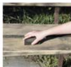
Odstraňte zbytky starého nátěru
