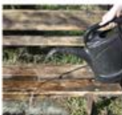
Omyjte povrch vodou – při silném zašednutí postup opakujte
