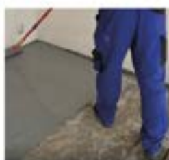
Napenetrujte podklad technikou křížového nátěru
