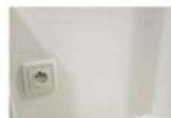
Finální povrch po aplikaci ROKOANTIBAC SYSTEMU, který chrání zdivo před působením mikroorganismů
