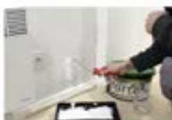
Provedte první nátěr. Doba zasychání mezi nátěry je zhruba 2–4 hod.
