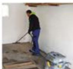
Očistěte praskliny v betonu a vysajte povrch
