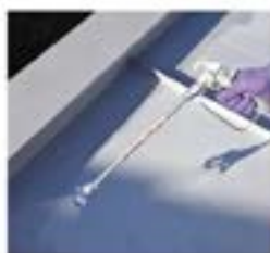
Nastříkejte vysokotlakým stříkacím zařízením (2 vrstvy)
