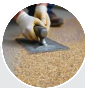
Pokládka povrchu TopStone
