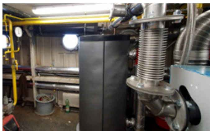
Instalace plynové kogenerační jednotky, kouřovodu s tlumičem hluku a komína v komínové šachtě | Botel Admirál, Praha, Česká republika
