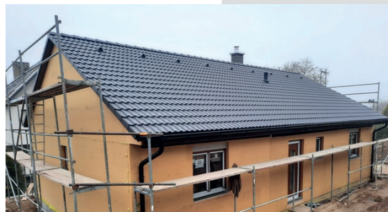
KROK 2 – Pokládka střešní krytiny
