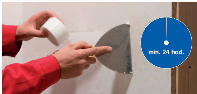
Obrázek č. 6: Výztužná páska – následuje min. 24 hod. technologická přestávka.
