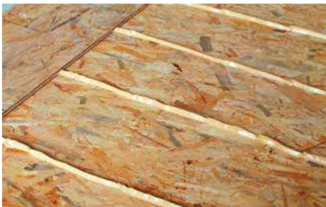
Obrázek 13 Lepení OSB desek pružným lepidlem pomocí pistole
