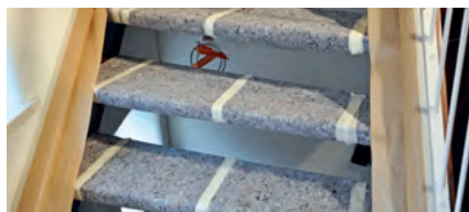
Otevřená schodiště: Lepicí páskou jen připevníte fólii
