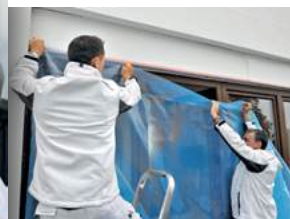
S běžnou maskovací fólií trvá práce podstatně déle a je mnohem těžší.
