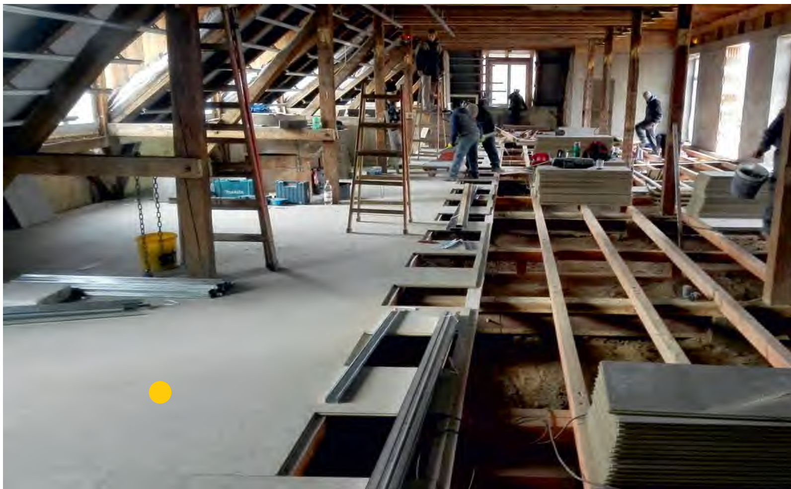
Montáž podlahy na nosnících, Chrudim Installation of a floor on beams, Chrudim (CZ)
