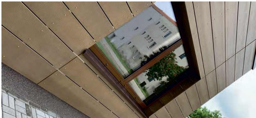
Odvětrávaná fasáda sportovní haly, Bohdaneč Ventilated facade of a sports hall, Bohdaneč (CZ)
