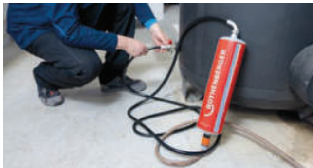
Plnění topných systémů v souladu s normami
