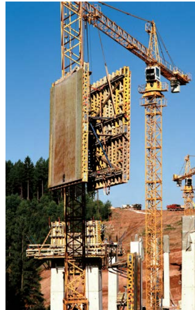
► Snadná montáž a demontáž bednicích sestav umožňuje bezproblémovou přestavbu v případě častých změn půdorysu
