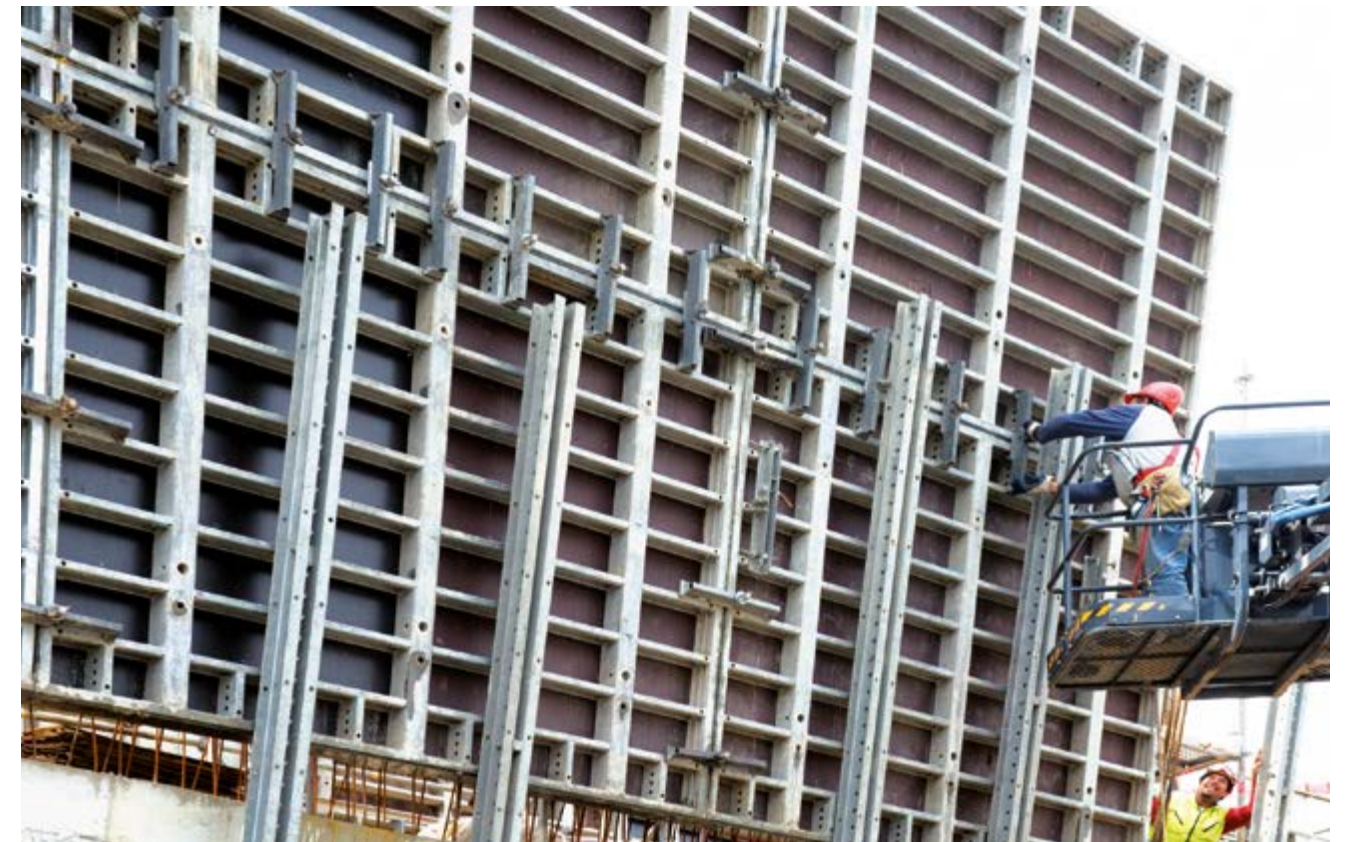
► Speciální řešení: Fasádní nosníky využity pro přesné a bezpečné zarovnání bednění MANTO do požadované šikmé polohy.
