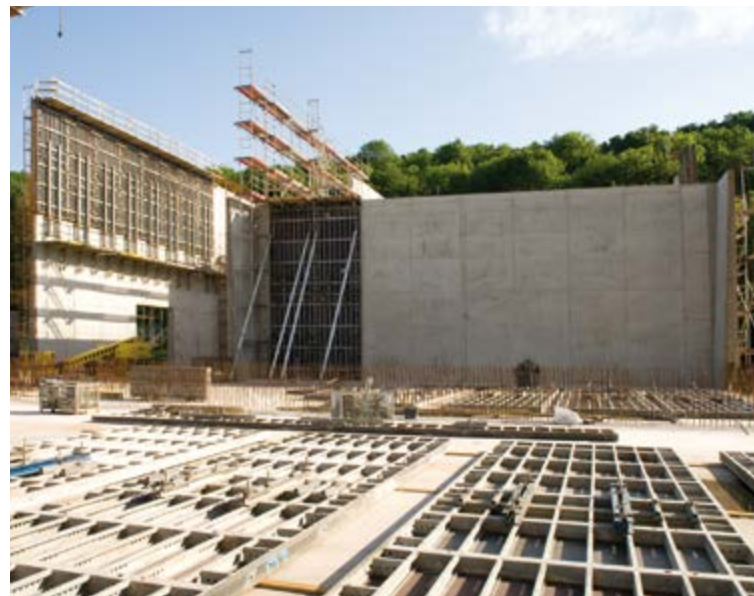
► Použitím fasádních nosníků byly stěny terminálu vysoké 16,73 m vybetonovány ve dvou cyklech betonáže namísto tří.
