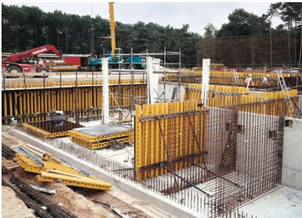
► Volný výběr bednicích desek poskytuje flexibilitu z hlediska požadované kvality povrchu betonu
