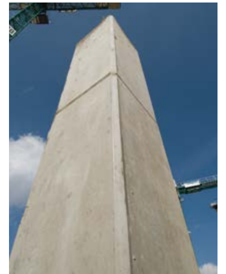
► Vynikající povrch betonu a možnost více opakovaných použití díky překližce potažené plastem
