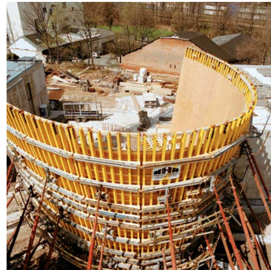
► Libovolné výšky elementů pro snadné dosažení požadovaného vzhledu betonu
