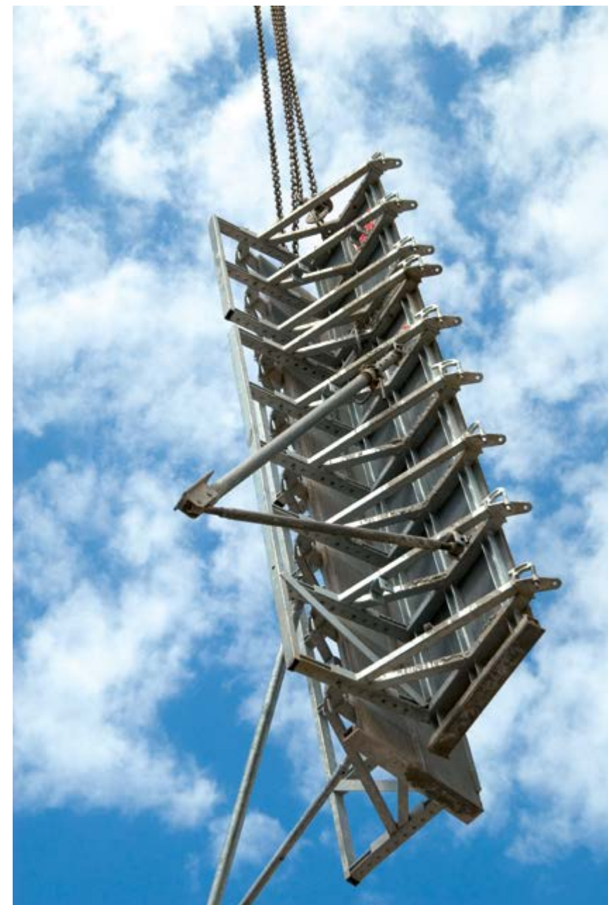
► Přesouvání sestavených kompletů pomocí jeřábu. Veškeré příslušenství je pevně připevněno k sestavě
