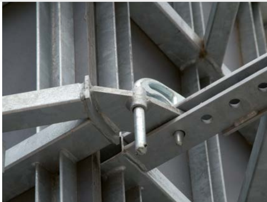
► Průřezy sloupů jsou nastavitelné po 5 cm
