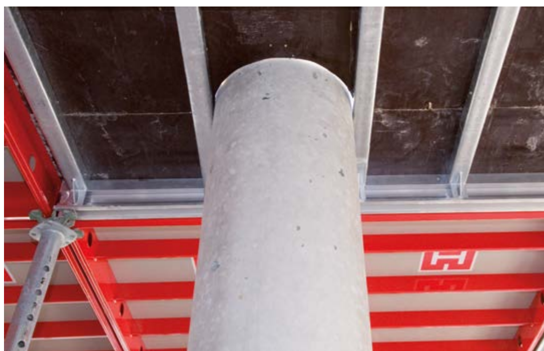
► Sloupy a další překážky lze snadno obejít pomocí nastavovacích řešení TOPEC
