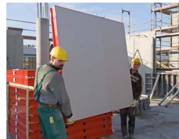
► Lehká hliníková konstrukce TOPEC zajišťuje ergonomickou manipulaci a dlouhodobě neúnavnou práci
