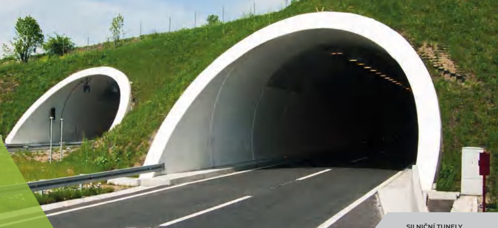
SILNIČNÍ TUNELY ROAD TUNNELS
