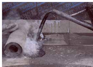
> Lepení prvního asfaltového pásu
