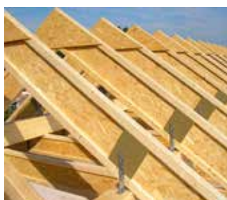
Kotvení krokve na pozednici – osedlání boční příložkou
