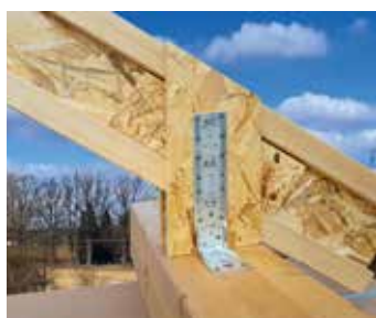
Schéma kotvení příložek
